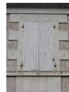
MOULURE ET ASSISES, LE CRÉPÉ, LA LAIGNE
