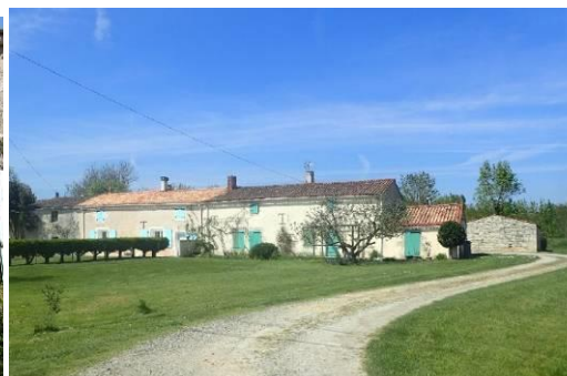
À PROXIMITÉ DU CANAL DE LA ROUTE D'EAU, TAUGON
