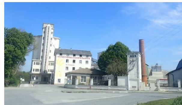
RUE DE LA MINOTERIE, COURÇON
