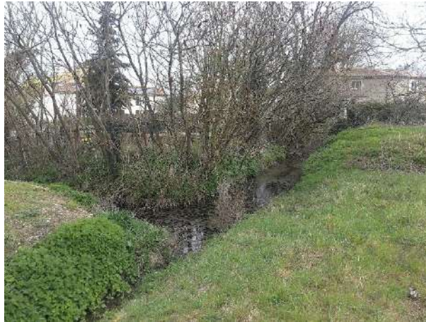
Figure 35 : Fossé – Loreau (Source : UNIMA)
