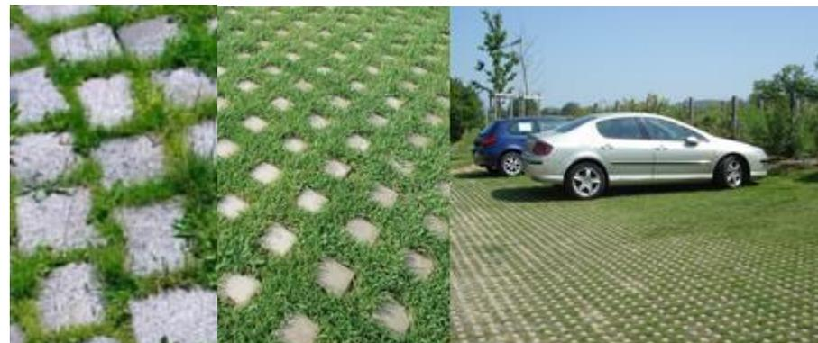
*Exemples de traitement respectueux de l'environnement : pavés enherbés ou béton poreux limitant la perméabilité des sols*
