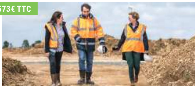
Visite de chantier © Mélanie Chaigneau
