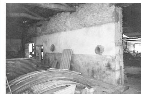
Intérieur de la maison, revers façade Est vers le hangar
