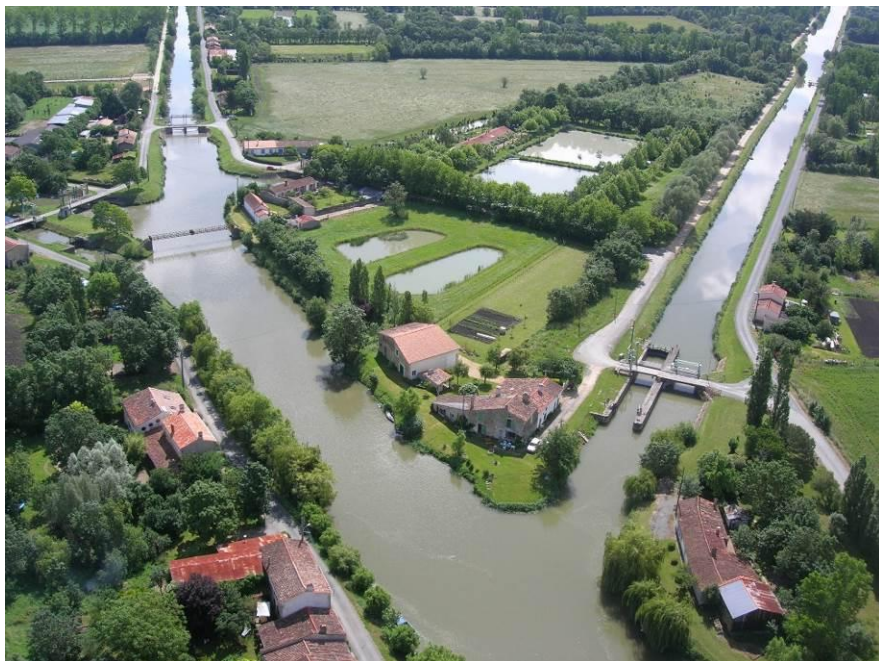
Nœud hydraulique de Bazoin - La Ronde
